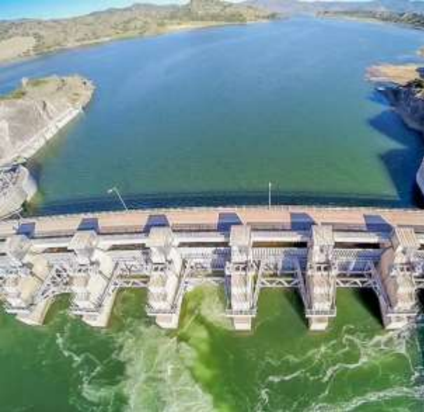
Resim 7: Kargı Hidroelektrik Santrali
